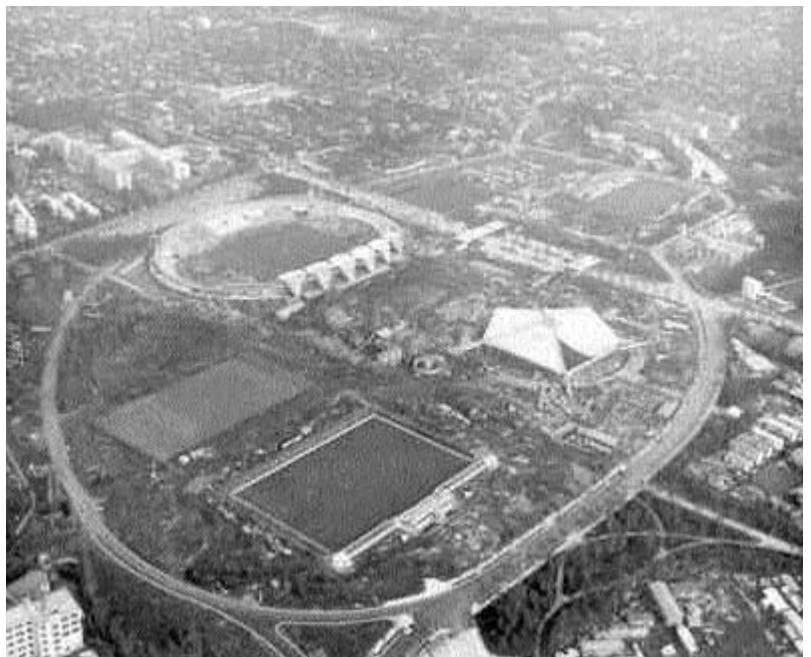
Olimpiadi di Tokyo, 1964. Costruzione delle strutture del Parco sportivo Komazawa
